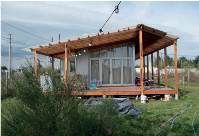
Foto 37 / D1 Seudónimo: Humedal "Habitar sobre el humedal" Villa Garibaldi, La Plata
