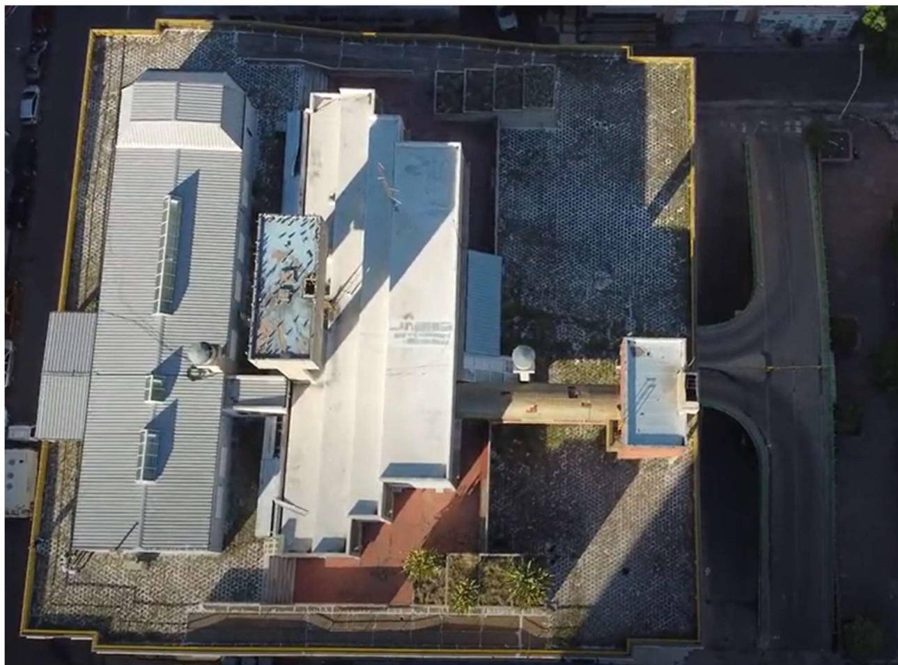
Imagen 9 – Foto aérea de la cubierta y terraza del Mercado Municipal (2024)
