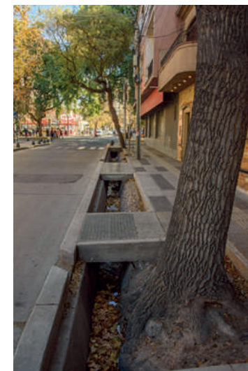
Foto calle Corrientes ciudad de Mendoza
